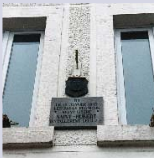
Plaque rappelant que les paras français entrèrent les premiers dans St. Hubert et installèrent leur PC dans la maison ( Rue du Marché n° 3 )
